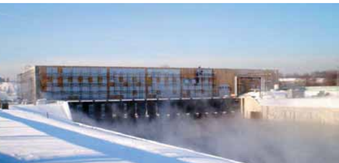
Самый большой в мире блок ультрафиолетового обеззараживания воды на Курьяновских очистных сооружениях, Москва (3 млн м 3 в сутки)
